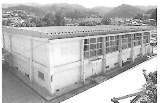
▶たかむち小学校校耐震工事後の体育館
