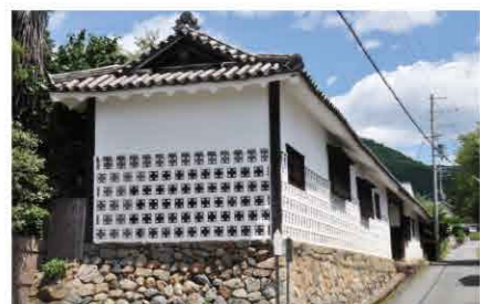
3 植村家長屋門 高取藩の家老・中谷家の長屋門。現在は旧藩主植村家の住居となっています。海鼠壁(なまこかべ)が特徴的で、県指定文化財です。
