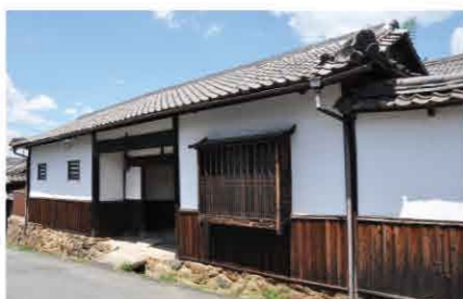
4 田塩家長屋門 白壁、腰部に下見板を張る武家屋敷の長屋門。装飾性と監視や防御を兼ねた出格子窓と与力窓(よりきまど)を2つ持っています。
