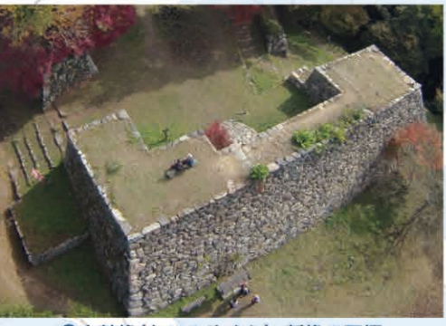
④太鼓櫓(たいこやぐら)・新櫓の石垣 本丸の手前に配置された特徴的な石垣です。昭和47年度に修復されました。この上に太鼓櫓・新櫓が建てられ堅牢な構造となっていました。
