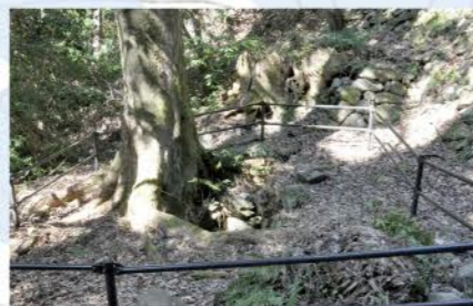
③七つ井戸 高取城の裏手(搦め手・からめて)側の急な斜面には七つ井戸と呼ばれる石垣造の井戸を四つ見られます。山城では水の確保が要となります。
