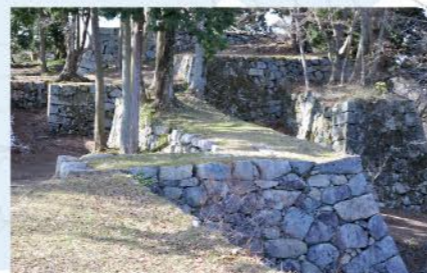
②本丸虎口の石垣 城の出入口を虎口(こぐち)と呼びますが、最も厳重な形式が樹形虎口(ますがたこぐち)です。本丸の樹形虎口は城内でも特に強固です。
