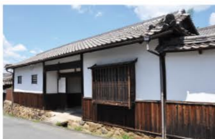
④ 田塩家長屋門 白壁、腰部に下見板を張る武家屋敷の長屋門。装飾性と監視や防御を兼ねた出格子窓と与力窓(よきまど)を2つ持っています。
