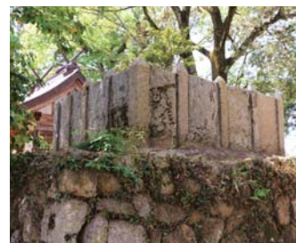
▲板石を盾状に立てた石垣
