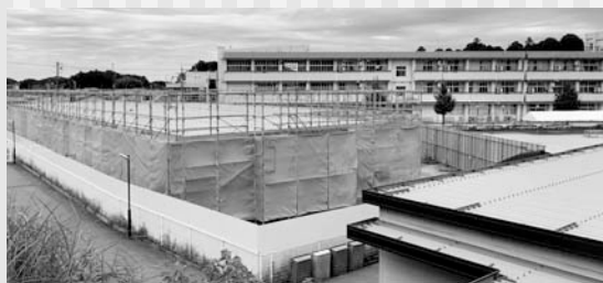
▲工事現場の様子
